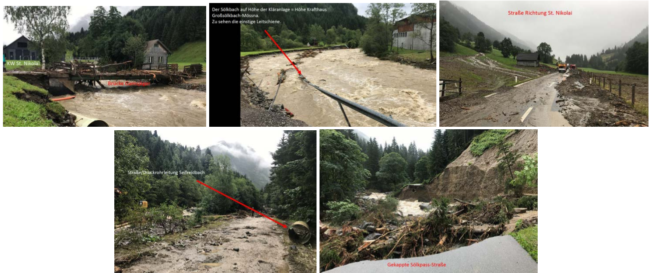
Abbildung 4: Fotos der Unwetterkatastrophe (lokale Starkniederschläge) von 4.-5.8.2017 im Großsölktal der Gemeinde Sölk, zerstörte Infrastruktur: Druckrohrleitungen der (neuen) Wasserkraftwerke des E-Werks Gröbming sowie verwüstete Straßen. © Ernst Trummer, E-Werk Gröbming
