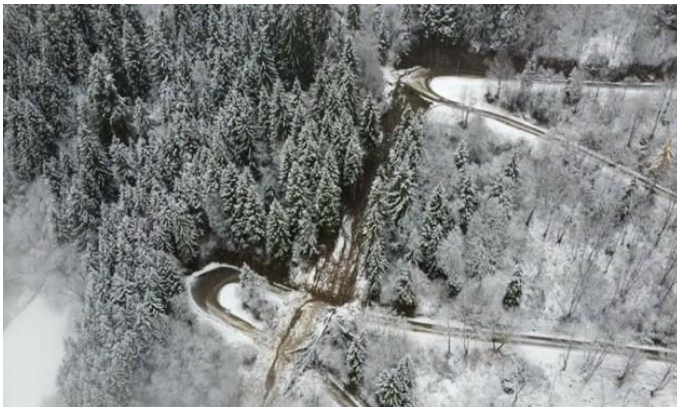
Abbildung 8 Maltabergstraße von Mure verlegt, Rüscher 2019
