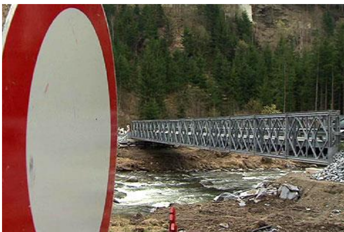
Abbildung 6 Behelfsbrücke Liesertal, ORF Kärnten 2014
