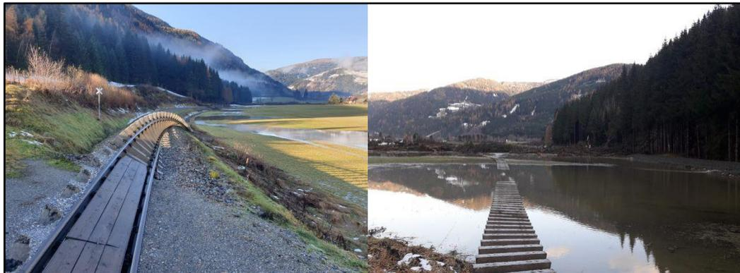
Abbildung 13: Beschädigung der Gleisanlage der Murtalbahn (Quelle: Holzwelt Murau)
